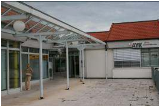
3. Bauabschnitt: „die Weißen“
