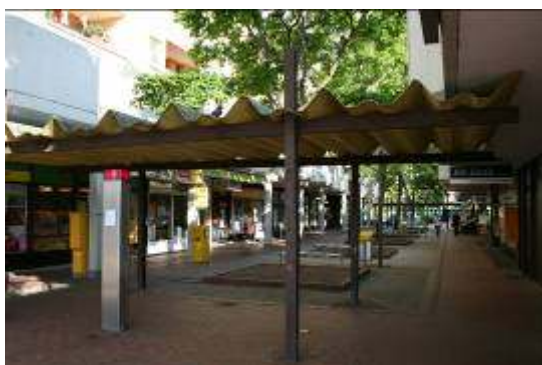
1. Bauabschnitt, Bereich Flamingoweg 20
